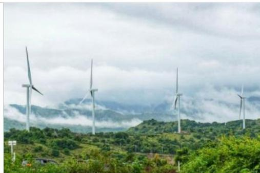
Kebanyakan tenaga angin modern dihasilkan dalam bentuk listrik dengan mengubah rotasi dari pisau turbin menjadi arus listrik dengan menggunakan generator listrik. Pada kincir angin, energi angin digunakan untuk memutar peralatan mekanik untuk melakukan kerja fisik, seperti menggiling bulir padi atau memompa air.
